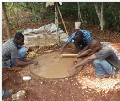
Réalisation dalle bombée
